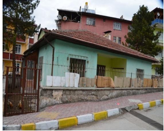
Eski Hizmet Binası
