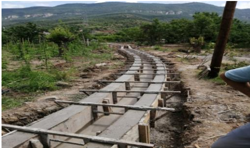
Resim 3- Yukarıkızılcaören Köyü S.S.T Kanal İnşaatı
