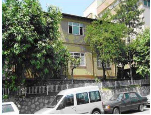
Eski Hizmet Binası
