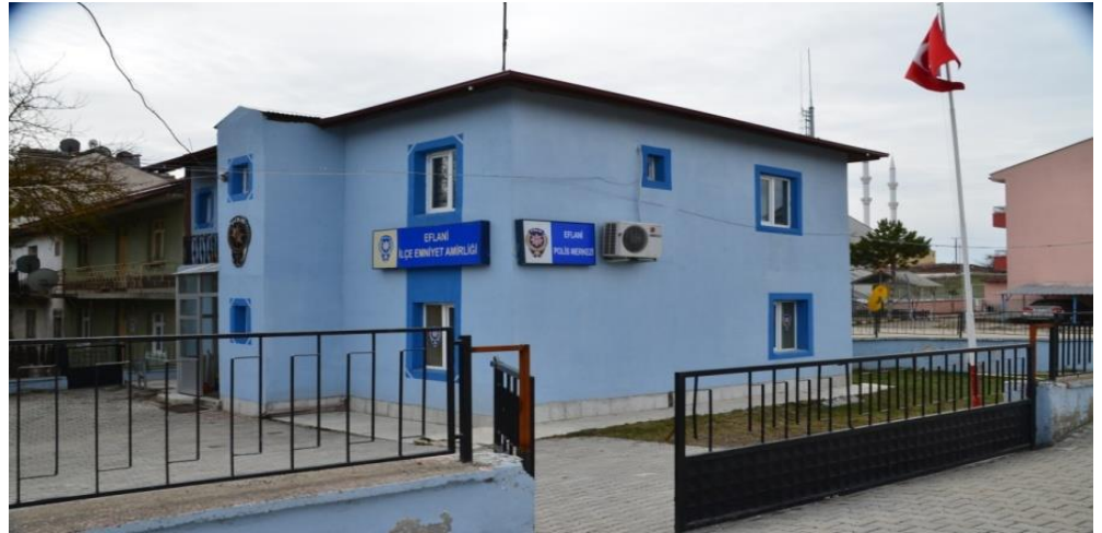
Eski Hizmet Binası
