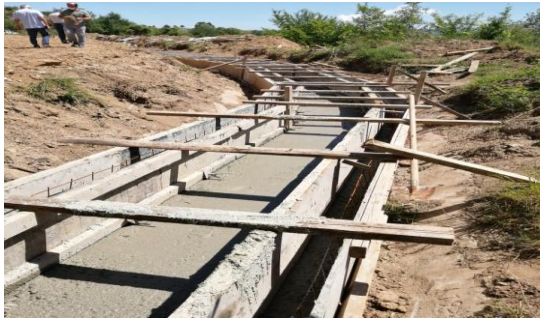
Resim 1-Bahçepınar S.S.T. Kanal İnşaatı
