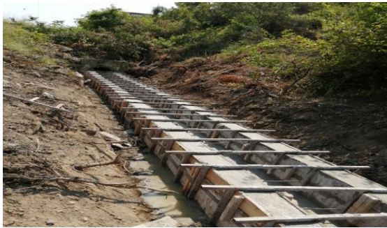
Resim 7- Burunsuz Köyü S.S.T. Kanal İnşaatı
