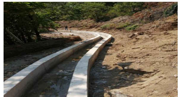
Resim 8- Burunsuz Köyü S.S.T. Yenilenen Kanal
