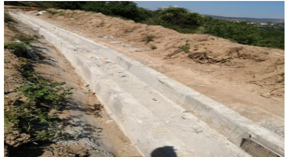
Resim 2-Bahçepınar S.S.T. Yenilenen Kanal
