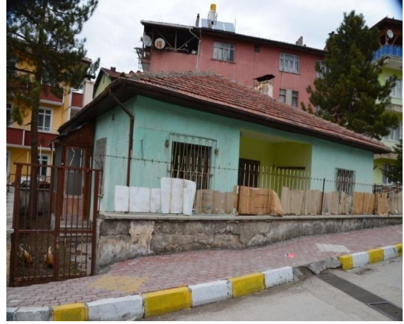
Eski Hizmet Binası
