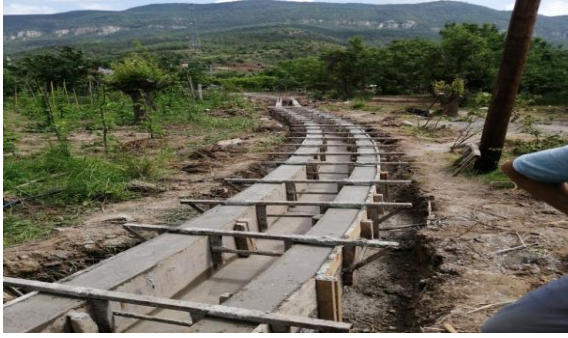
Resim 3- Yukarıkızılcaören Köyü S.S.T Kanal İnşaatı
