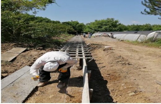
Resim 5- Yukarıkızılcaören S.S.T. Kanal İnşaatı
