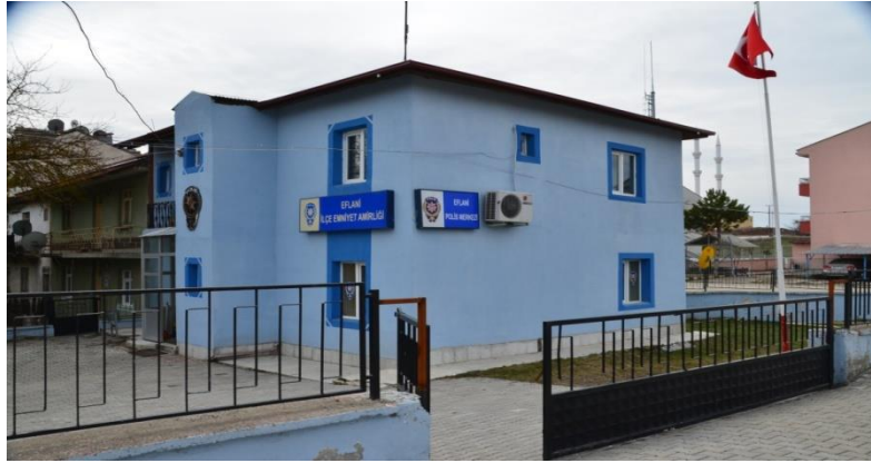
Eski Hizmet Binası
