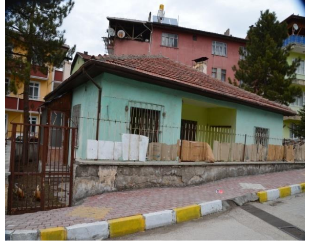
Eski Hizmet Binası
