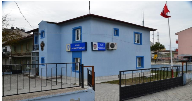
Eski Hizmet Binası
