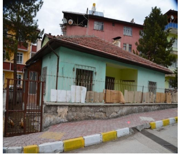
Eski Hizmet Binası
