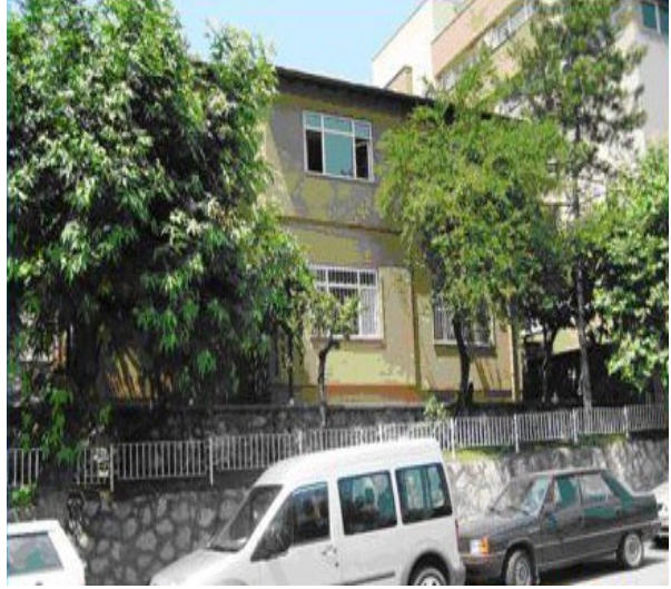
Eski Hizmet Binası
