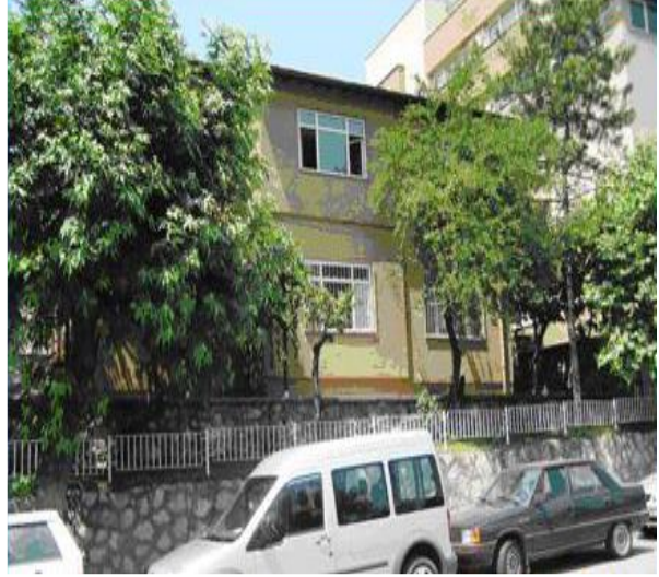
Eski Hizmet Binası
