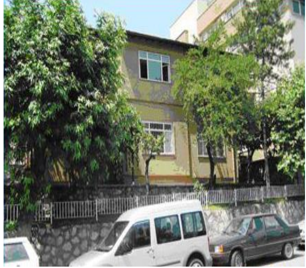
Eski Hizmet Binası
